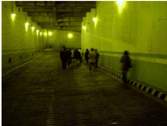
【中間処理場地下3Fへ（一般ごみ圧縮所）】
